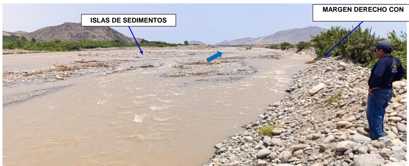
FIGURA N°03: RIO CHANCAY-HUARAL, CON EL CAUCE COLMATADO CON ISLAS DE SEDIMENTOS Y CON LOS BORDES EN AMBOS LADOS EROSIONADOS POR EL CAUDAL CON RIESGO A DESBORDE QUE AFECTARIA A DIFERENTES ACTIVIDADES EN AMBOS LADOS DEL RIO.
