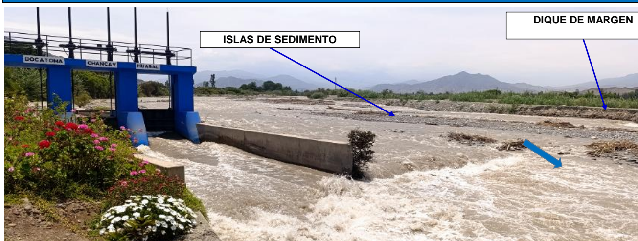
FIGURA N°01: RÍO CHANCAY-HUARAL, TRAMO CRITICO SECTOR BOCATOMA CHANCAY-HUARAL, DIQUE IZQUIERDO EROSIONADO Y
