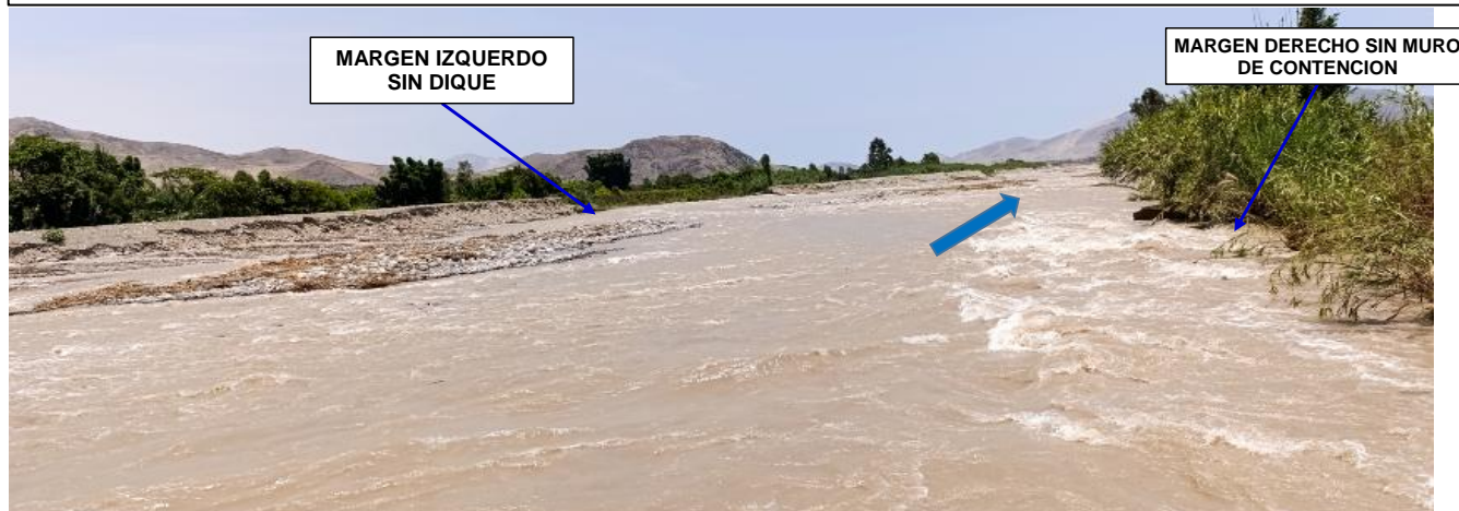
FIGURA N°02: CAUCE DEL RIO CHANCAY-HUARAL, CON PRESENCIA DE ISLAS DE SEDIMENTOS, DESVIANDO EL CAUDAL HACIA LOS BORDOS CAUSANDO EROSION EN LOS DIQUES Y TRAMO EN LA MARGEN IZQUIERDA SIN DIQUE.
